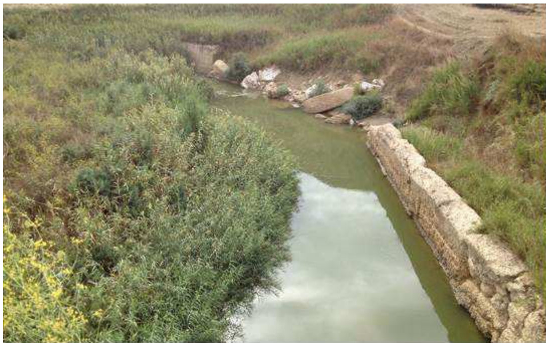
Foto n° 2 – Condizioni dell'alveo a monte del Ponte della S.P. n° 23 sul Fiume Gallo D'Oro.
