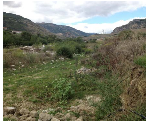
Foto n° 6 – Località Cozzo degli Ulivi – Accumuli di materiale litoide nella pianura alluvionale in sx idraulica verso monte
