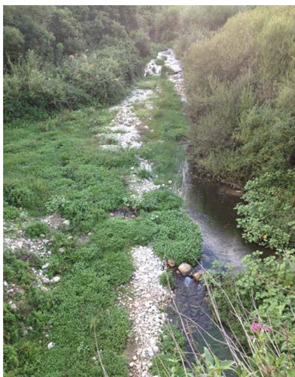
Foto n° 2 – Vista del corso d'acqua a monte del Ponte S. Pietro sulla S.P. n° 79 –
