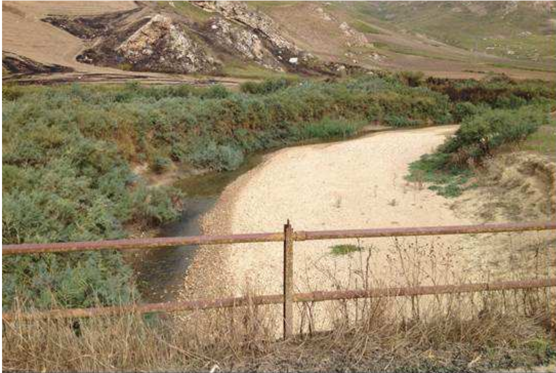
Foto n° 5 – Alveo del Fiume Salito, in corrispondenza del Ponte sulla S.P. n° 23 – Tratto di monte
